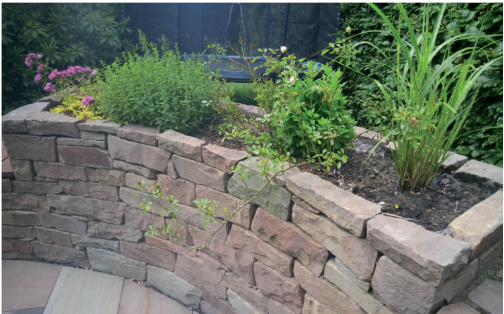
Trockenmauer als Einfassung eines kleinen Hochbeetes.
