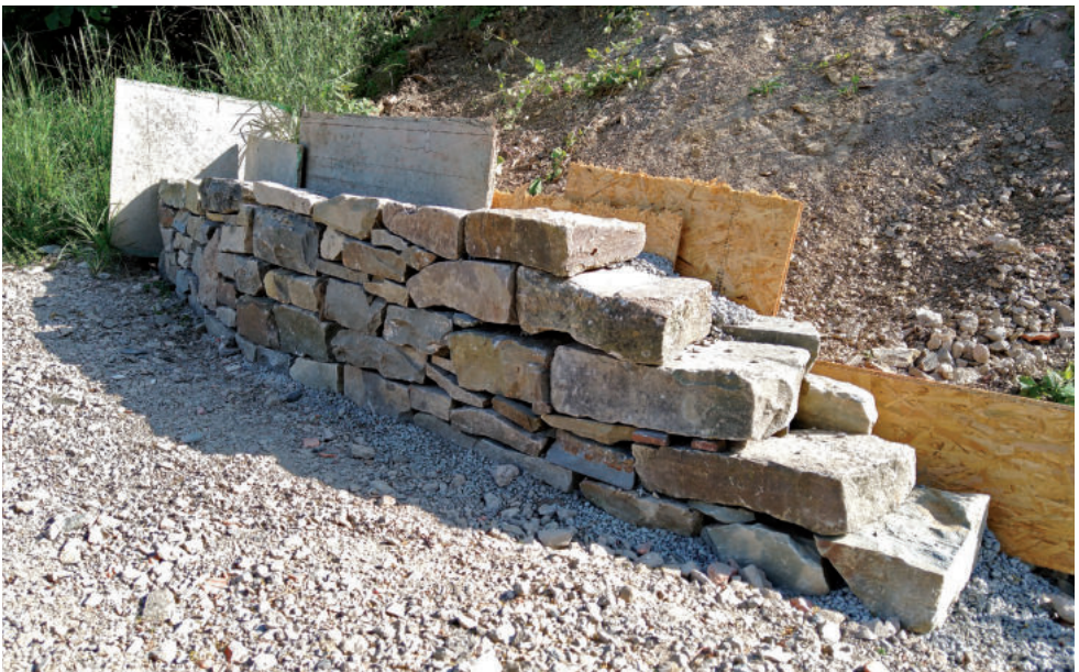
Die Trockenmauer auf dem Gelände der VHS Oberberg im Bau.
